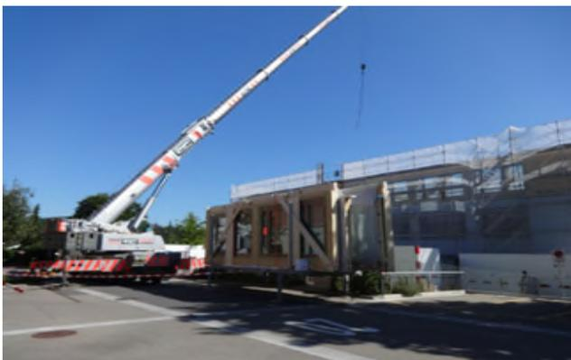
Mit Tieflader-Lastwagen wurden die Treppe, die Innen- und Aussenwände und die Dachelemente angeliefert. Der Pneu Kranführer platzierte sie, mittels Funk durch den Montagebauleiter geführt, Stück um Stück am richtigen Ort. Alles hat gepasst, alles hat geklappt. Innert zwei Tagen hatte das Haus ein zweites Stockwerk. Der Innenausbau wird bis ca. Mitte Dezember dauern.
